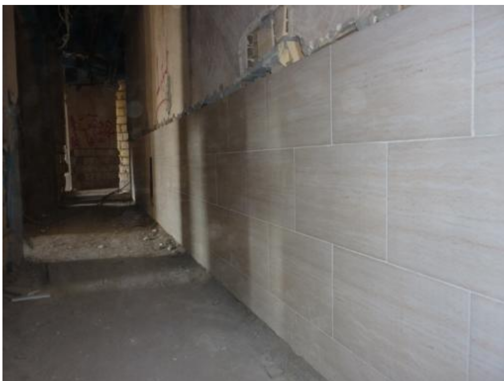
کاشی کاری بدنه راهرو بلوک F1
