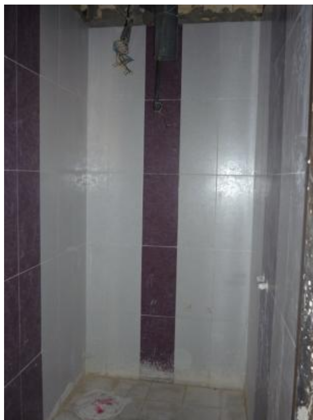
کاشی کاری سرویس و حمام بلوک A
