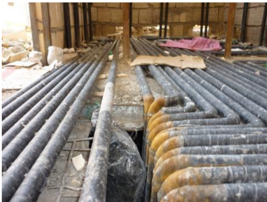
لوله کشی گاز کنتورهای جنوبی
